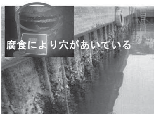
機能保全工事の実施 【着工前】
