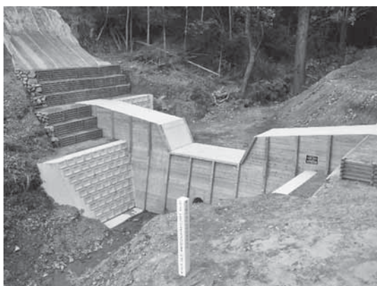
溪間工（谷止工）
