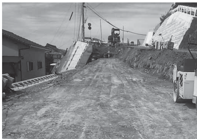
主要地方道：水俣田浦線（福浦3）（葦北郡津奈木町合串～葦北郡津奈木町福浦）
