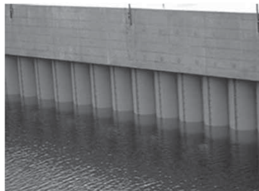
機能保全工事の実施 【竣工】
