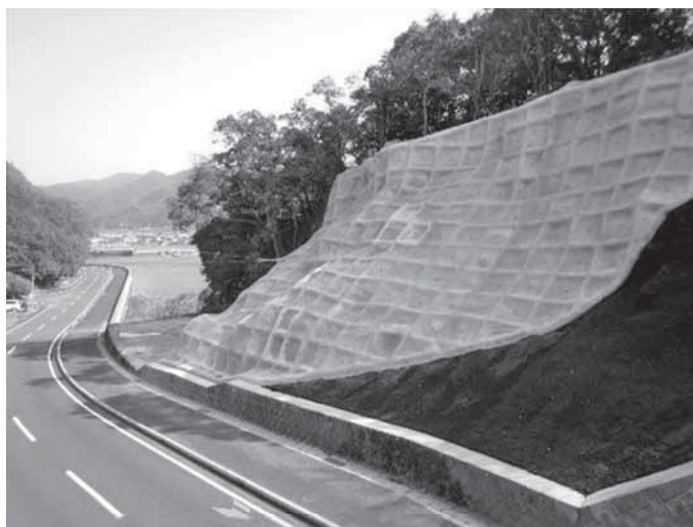
道路防災対策事業（水俣田浦線：津奈木町）
