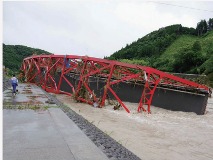
流出した相良橋
