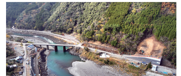
鎌瀬橋(八代市坂本町)の仮橋
