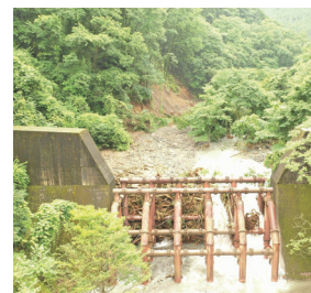
砂防堰堤の堆積土砂撤去(あさぎり町西平川)
