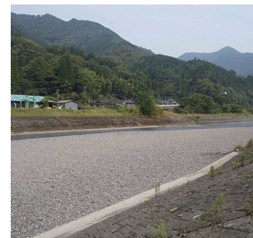
川辺川(五木村宮園)の掘削状況
