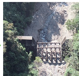
砂防堰堤の堆積土砂撤去(あさぎり町西平川)
