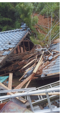
「令和2年7月豪雨」で土砂に押しつぶされ全壊した矢野さんの自宅(本人提供)
