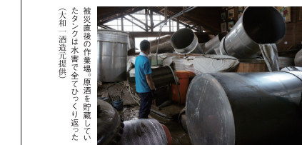
被災後の焼酎の工場。原酒を貯蔵しているタンクは水害で多く倒壊した(左)焼酎元造り提供
