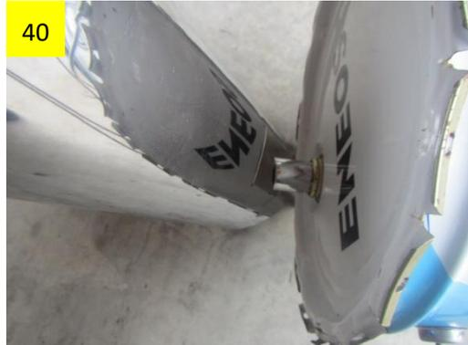
煙突の切り欠き部分にセルクル排煙口を入れるようにします。
