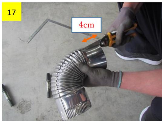
エルボの窯とつながる側に金切り鋏で4cm程度の切り込みを入れます。切り込みの間隔は曲げやすい程度の間隔で入れます。
