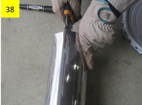
排煙口とつなぐため金切り鋏で煙突を切り欠きます。
