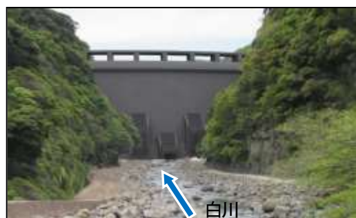
上流側からダムを望む
