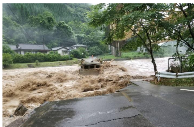
【橋梁流失】万江足算瀬地区
