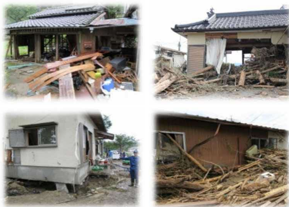
住家被害の状況
