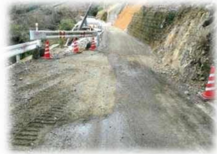
村道中尾線仮復旧後
